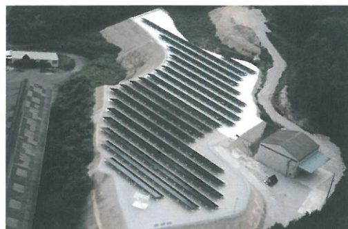
図. 2 施工事例全景航空写真
